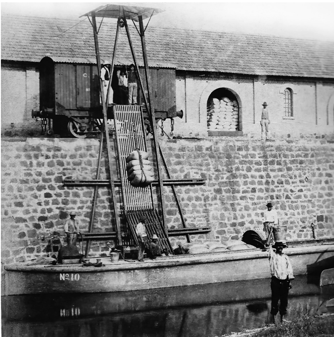
Figura 36: Desembarque de café no cais de Porto Ferreira. Fonte: FEPASA. In: REIS, 2010, p. 118.
