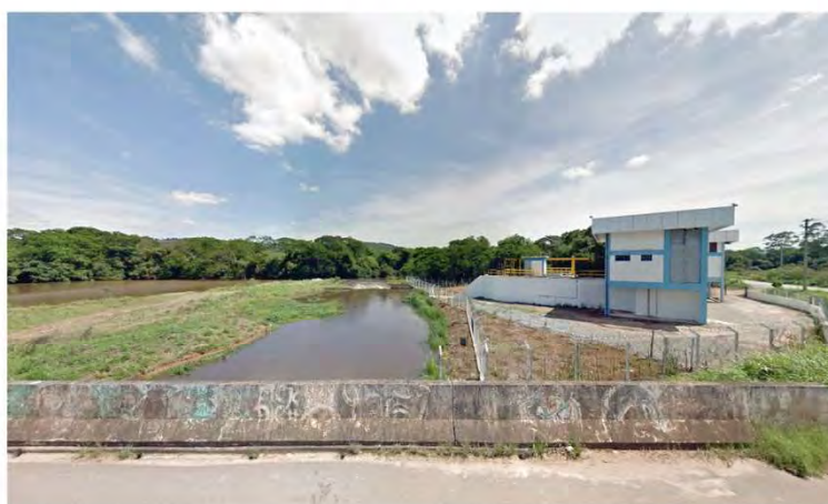
3 Captação de água no Sorocamirim às margens da Rodovia Prefeito Quintino de Lima.
