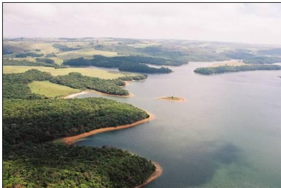
Figura 22 – Vista parcial da represa Itupararanga. Fonte: SOS Itupararanga/Fundação Florestal.
