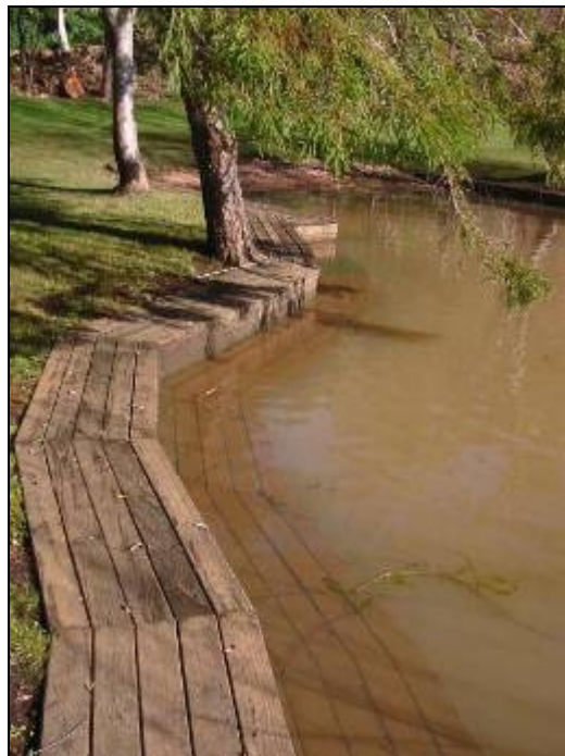
Figura 38 – Retenção de solos na margem do corpo de água. Evita a erosão e serve de cais, tanto em época de enchentes quanto em épocas de baixas. Fonte: Maritza Vuscovich, 2005.
