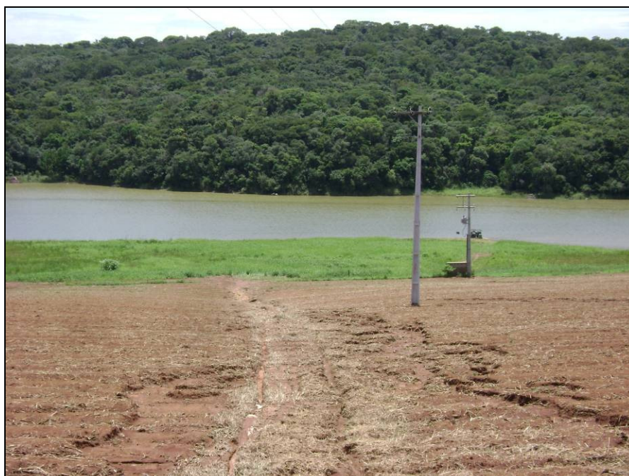
Figura 12 – Erosão de uma encosta dentro da APA na área do estudo, produto da atividade agrícola. Fonte: José L. R. Vuscovich, 2010.
