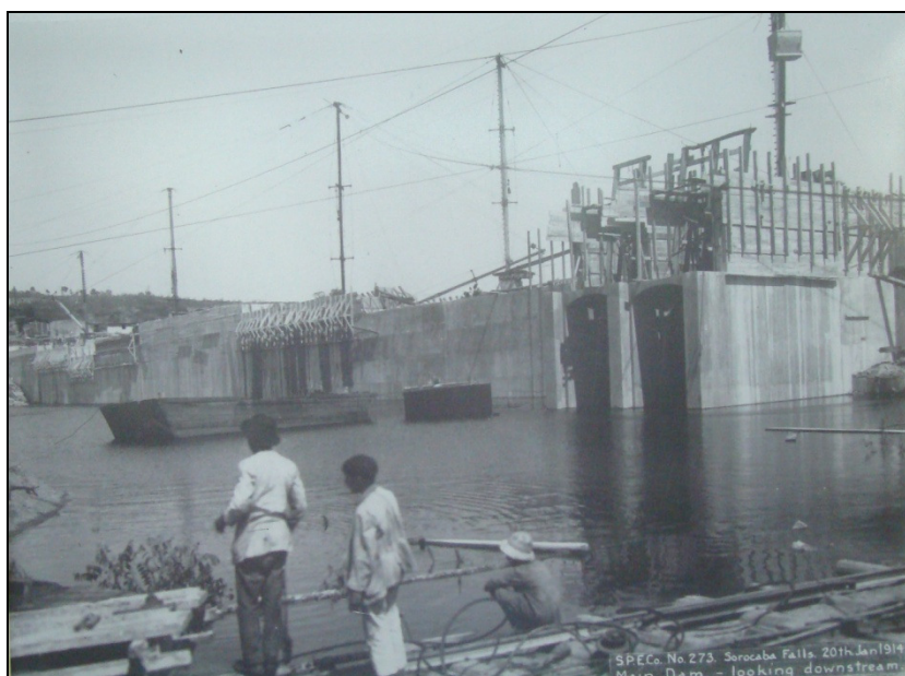
Figura 6 – Construção da barragem da represa de Itupararanga. Fonte: CBA – Companhia Brasileira de Alumínio, 1914.
