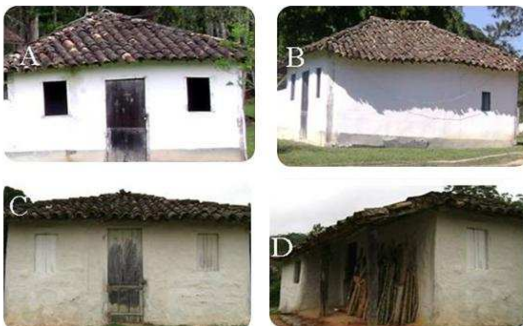
Figura 12 – As duas construções em pau a pique mais antigas do bairro. (A e B) Vistas da casa que pertenceu a Paulino Paulo, com aproximadamente 80 anos, desocupada, desde a morte da esposa Catarina; (C e D) Casa que pertenceu a um cunhado de Paulino Paulo, com cerca de 90-100 anos, hoje residência de Hélio e Matilda Domingues.
