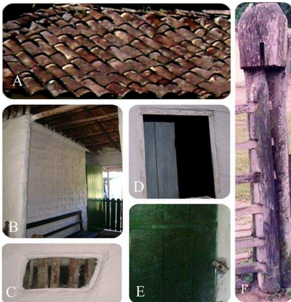
Figura 10 - Sistema construtivo e carpintaria. (A) Detalhe das telhas produzidas pelos moradores do bairro; (B) vista interna de uma construção em pau-a-pique ; (C) abertura para ventilação e iluminação em parede de pau a pique; (D e E) detalhe de porta e janela confeccionadas em folhas de madeira em sistema de encaixe. A porta com mais de 100 anos pertenceu a residência de Benedito Paulo. (F) portão construído em sistema de encaixe.
