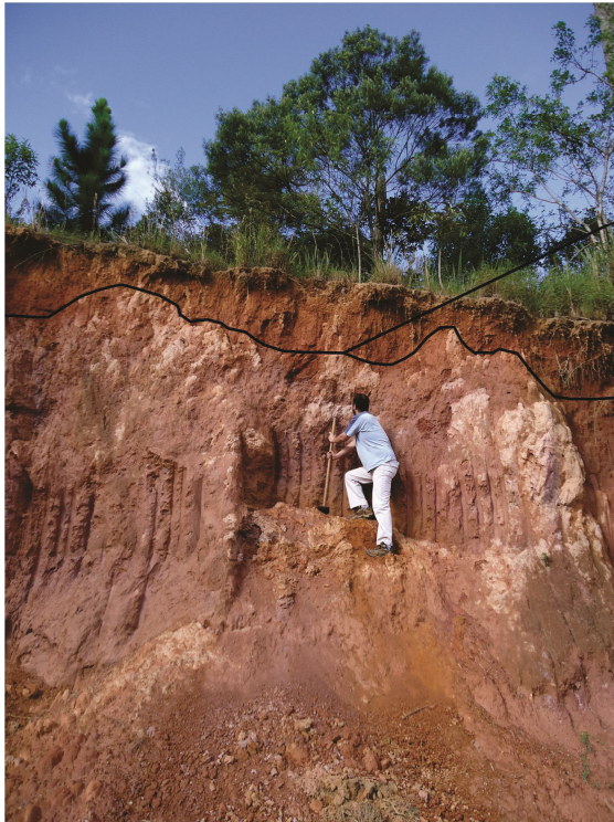
Observa-se 1,20m aproximadamente de solo vermelho/amarelo sobre profundo material de alteração domigmatito, 5 metros aproximadamente.
