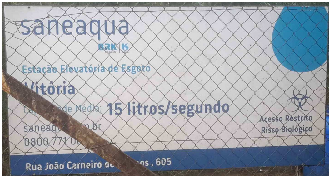
Vista da Placa de Identificação da EEE Vitória.
