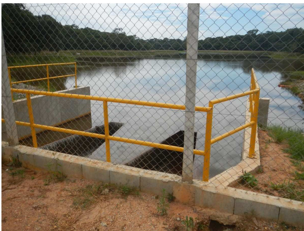
Vista do ponto de captação na Represa do Fiscal
