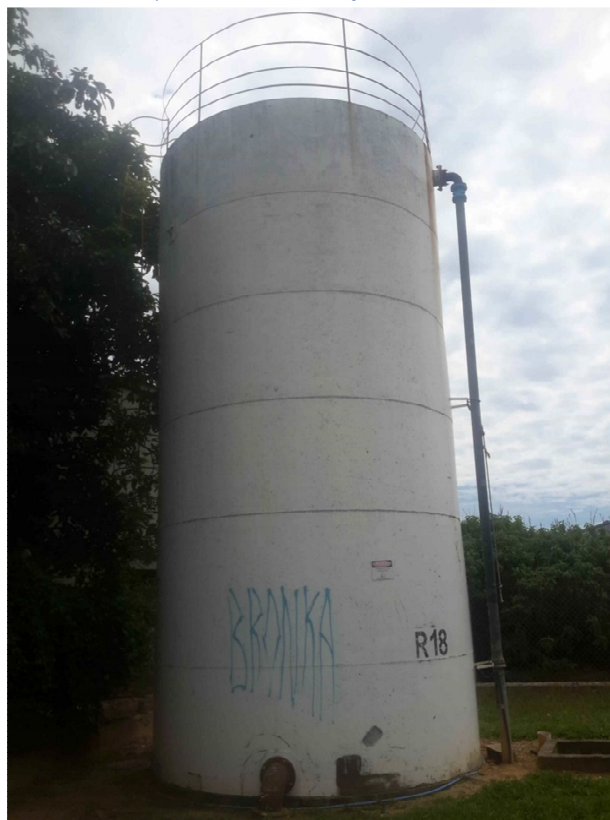
Vista do Reservatório metálico pertencente ao CR Reneville.
