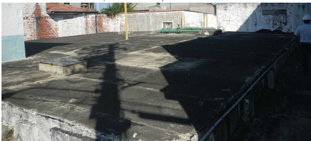
Vista do Reservatório semi enterrado do CR Granada R-12.
