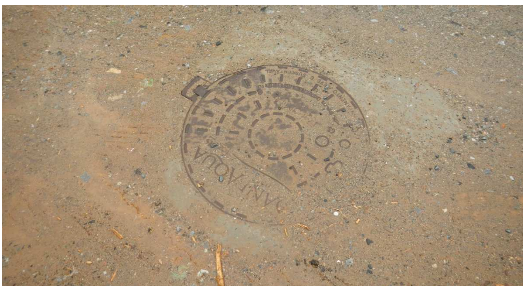
Vista de Tampão de acesso ao Poço P-16.
