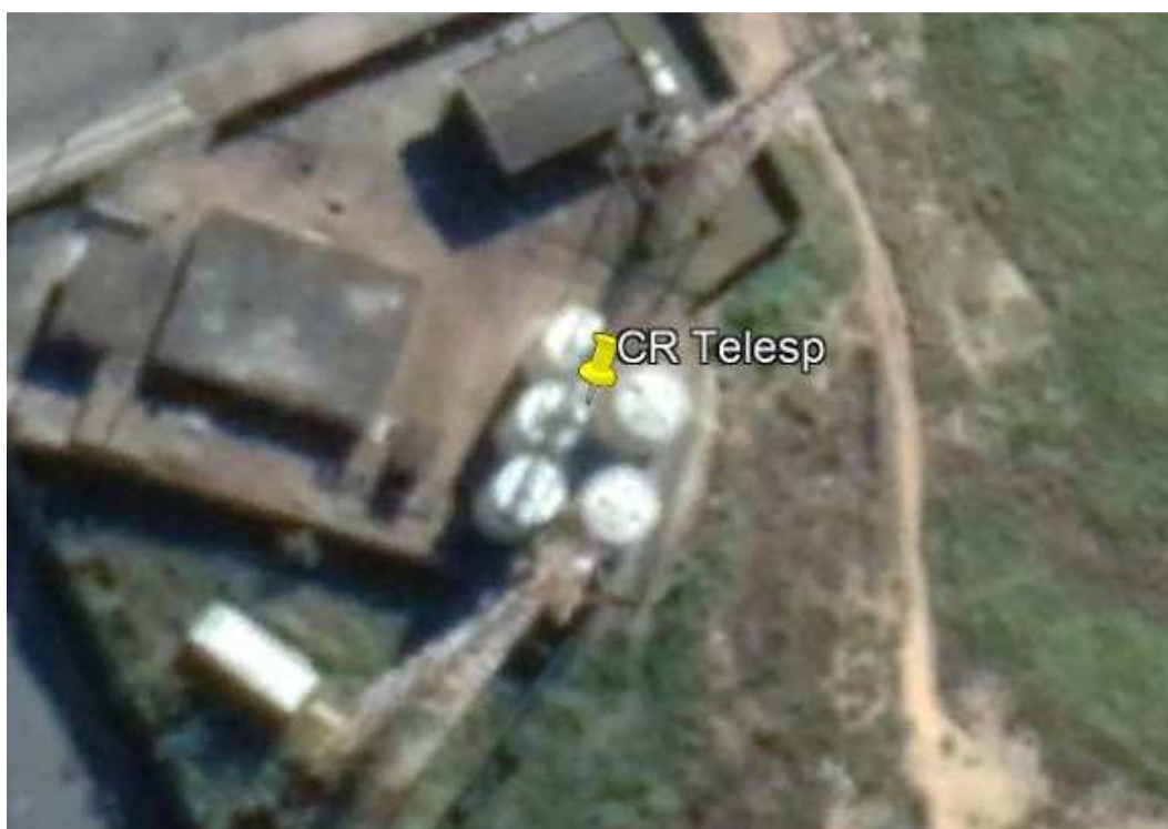
Vista superior exibindo os cinco reservatórios que compõem o CR Telesp.
