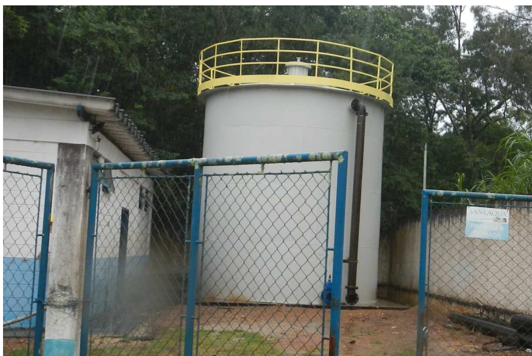
Vista do outro reservatório instalado na EEAT Waldez.
