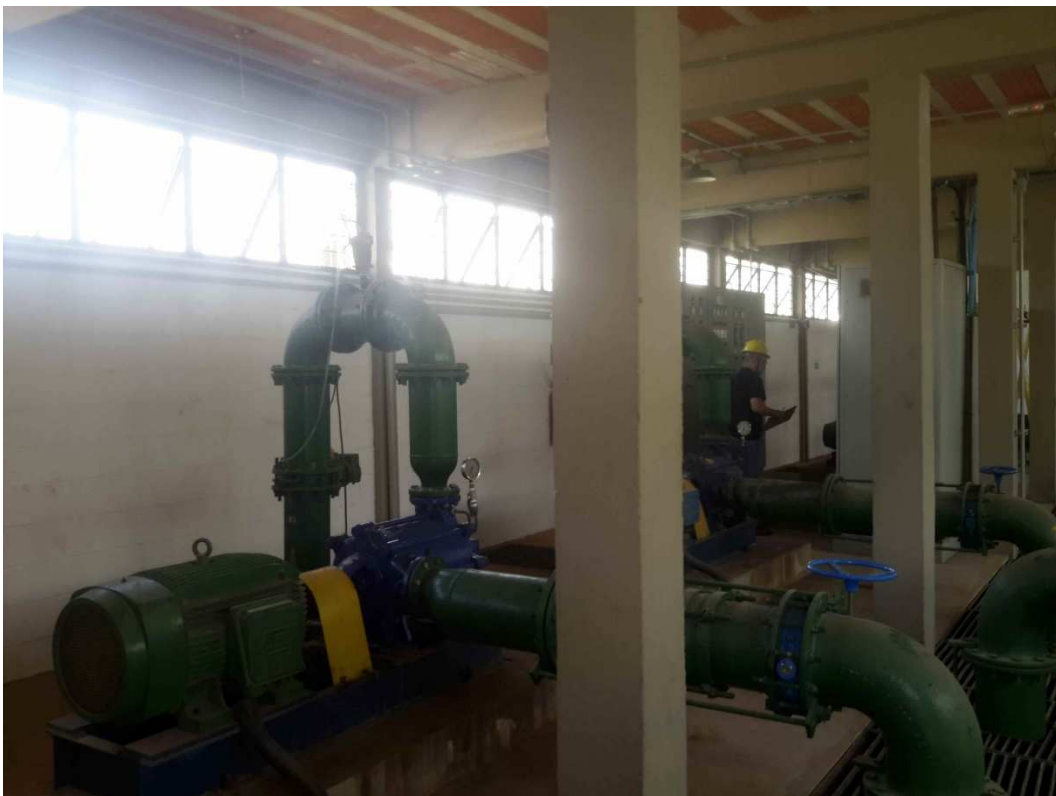
Vista do conjunto 1 de moto-bombas da EEAT – ETA.
