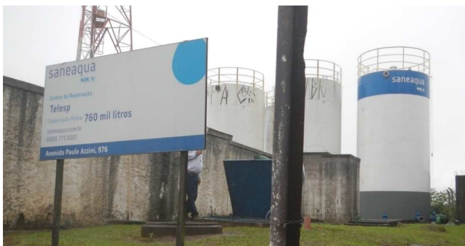
Vista da placa de identificação e os reservatórios metálicos ao fundo.
