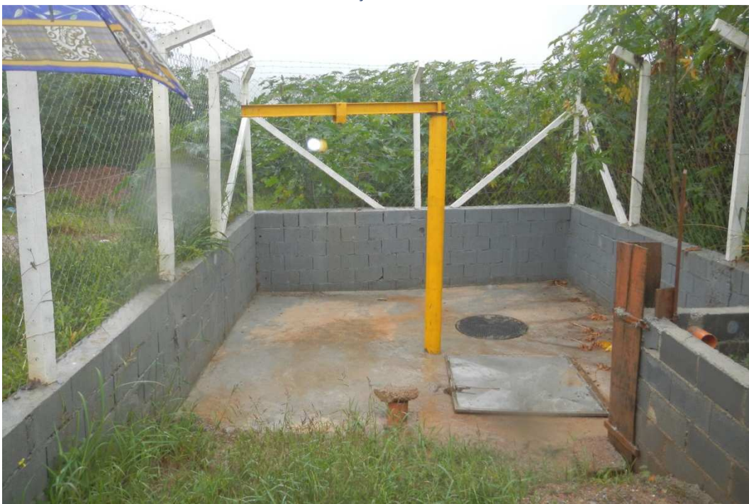
Vista Externa das instalações da EEE Vitória Zona Alta.
