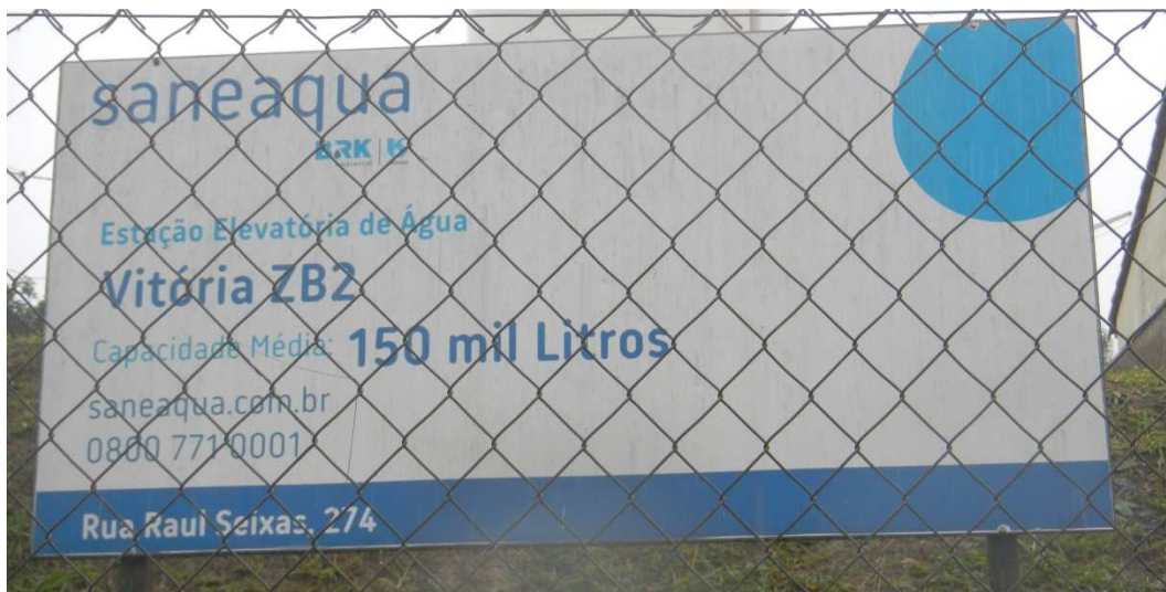
Placa de identificação da EEAT Vitória ZB2.
