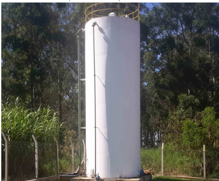
Vista do Reservatório Metálico pertinente ao CR São Camilo.
