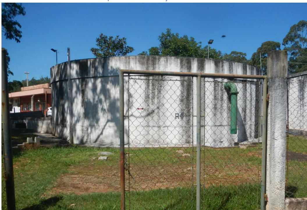
Vista do Reservatório identificado R4 integrante do CR Bombeiro.
