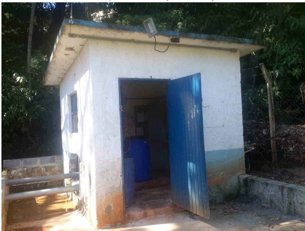
Vista das instalações da EEAB Jardim D'Oeste e Poço P-19
