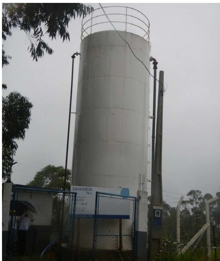
Vista do Reservatório Metálico pertinente ao CR Arco-Íris.
