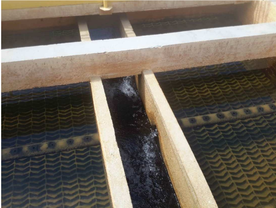
Detalhe da Estação de Tratamento de Água - Plataforma entre Filtros e Decantadores
