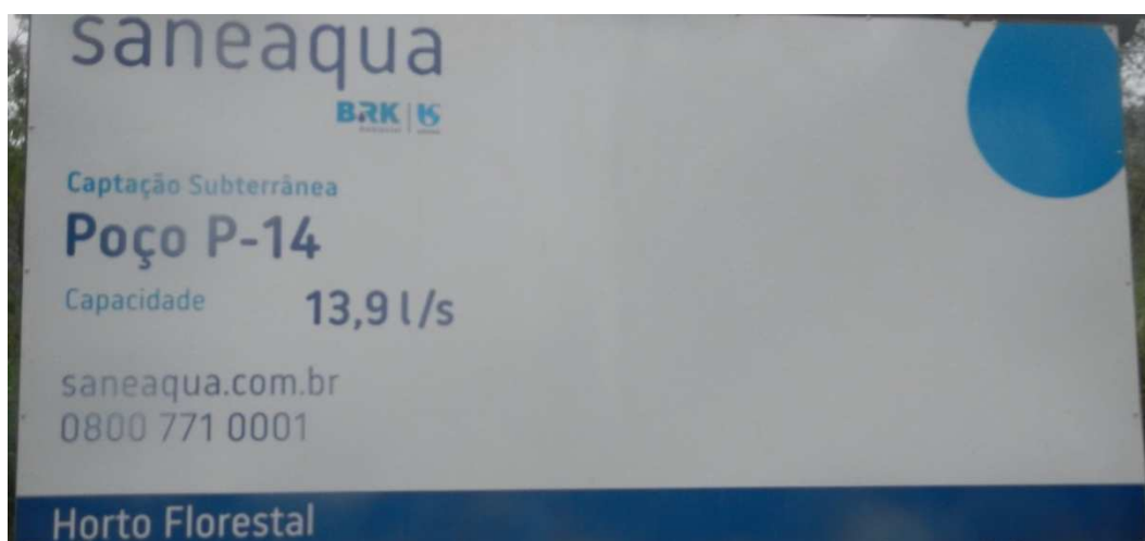
Vista da Placa de Identificação do Poço P-14.
