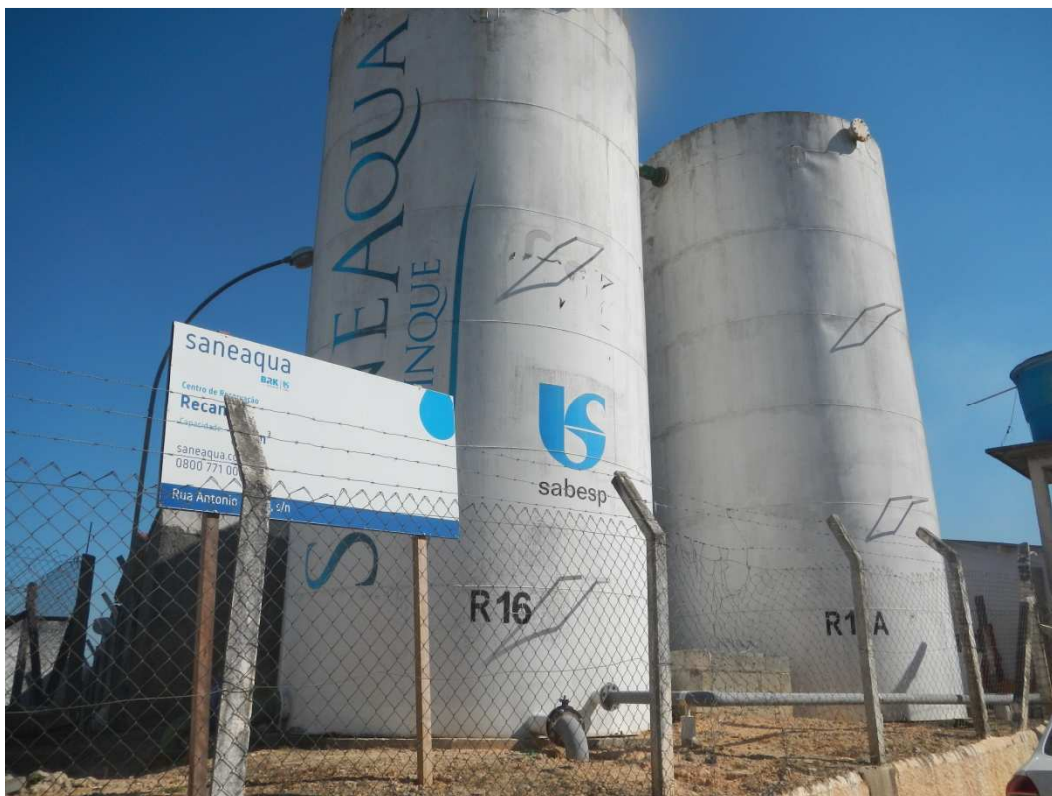
Vista dos reservatórios metálicos do CR Recanto.
