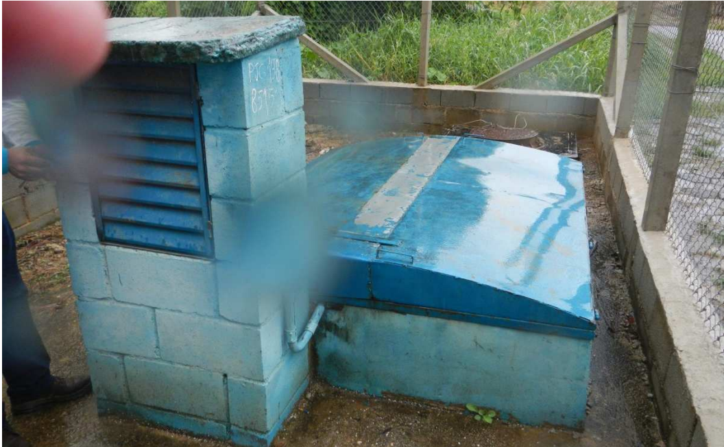
Vista externa das instalações da EEE Nova Mairinque.
