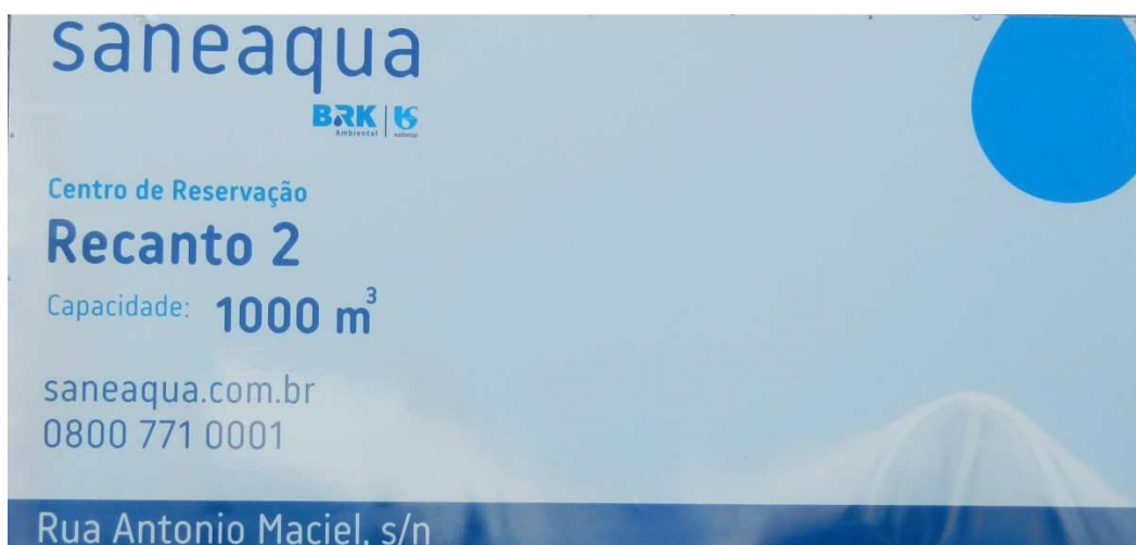
Vista da Placa de Identificação do CR Recanto 2.
