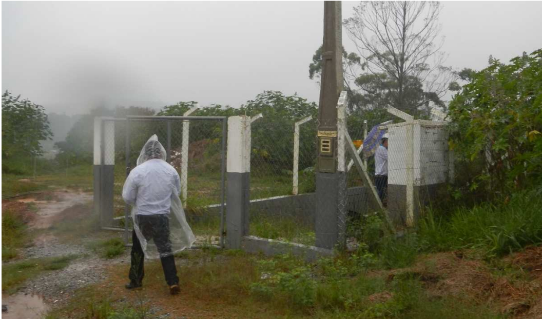
Vista Externa das instalações da EEE Vitória Zona Alta.
