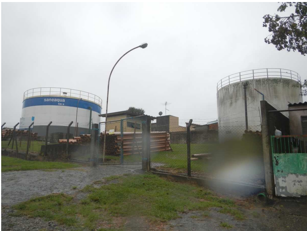
Vista do conjunto de reservatórios pertencentes ao CR CECAP.
