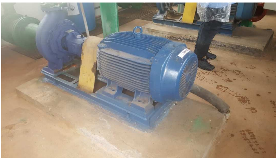
Vista do primeiro conjunto moto bomba instalada na EEAT Ginásio.
