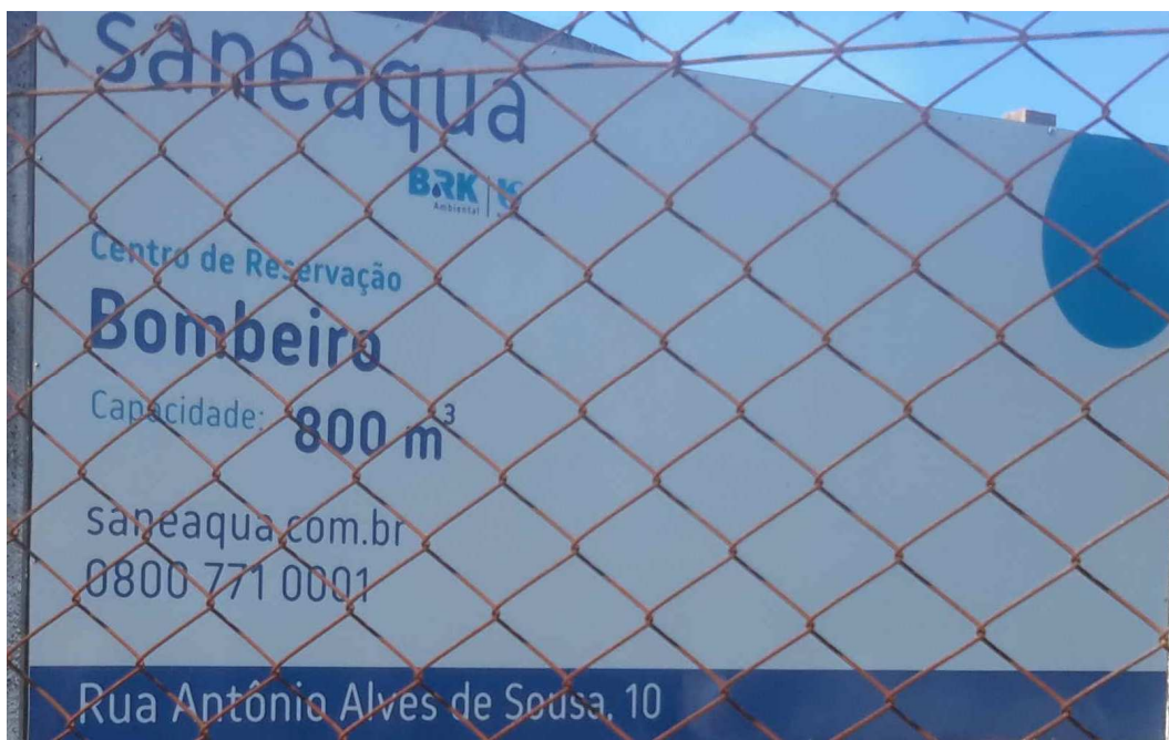
Vista da placa de identificação do CR Bombeiro.
