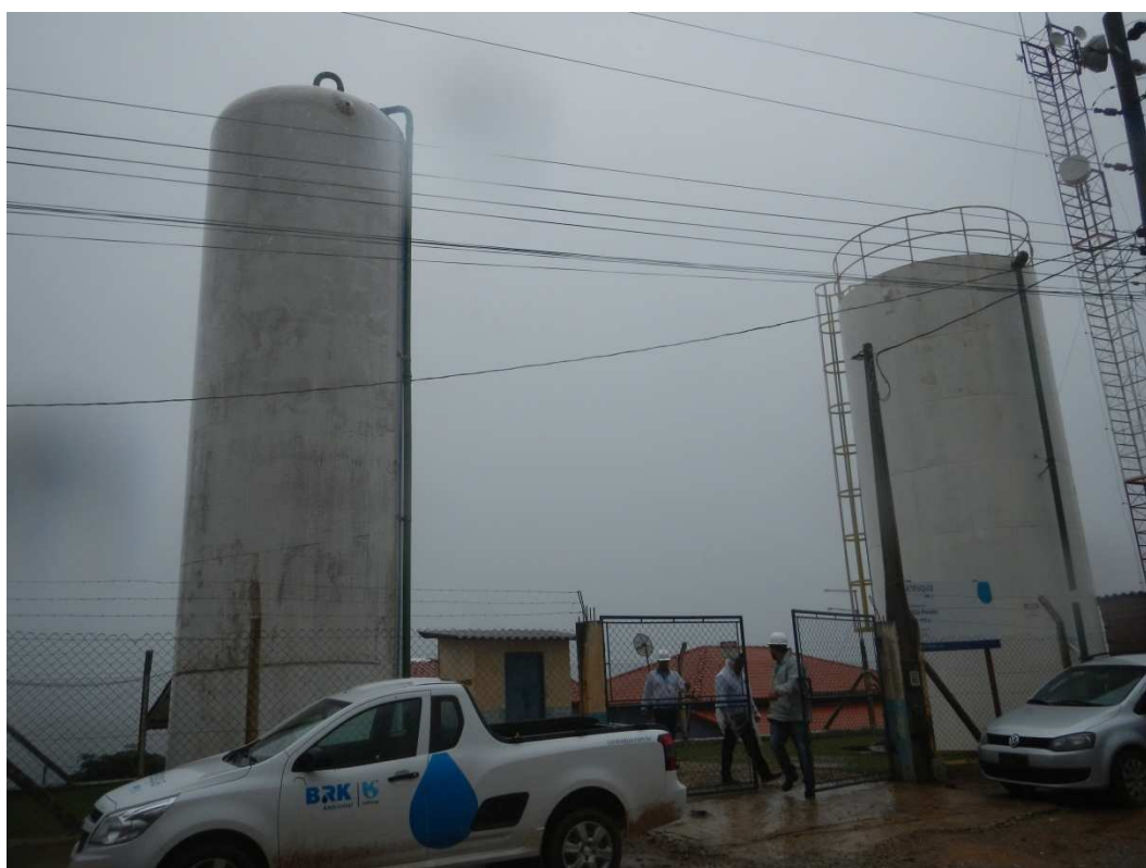
Vista dos 2 reservatórios metálicos que compõem o CR Cacilda Mendes.
