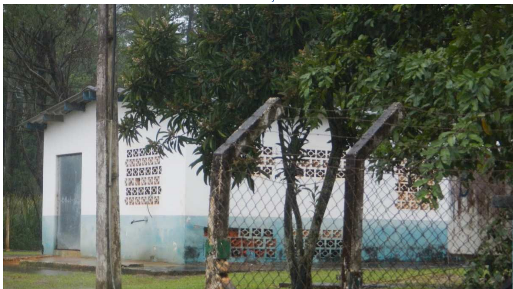
Vista Externa da EEAT Vitória ZB.
