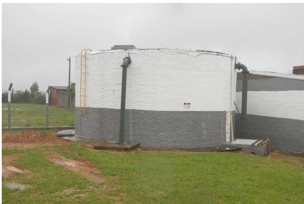
Vista do reservatório pertinente ao CR Flora.
