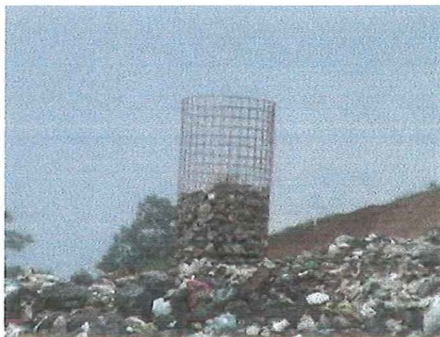
Figura 19: Dreno de gases executado em tela e brita (aterro de Guarulhos/SP)
