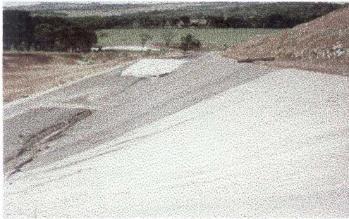
Figura 12: Impermeabilização de base e laterais (aterro de São Carlos/SP)
