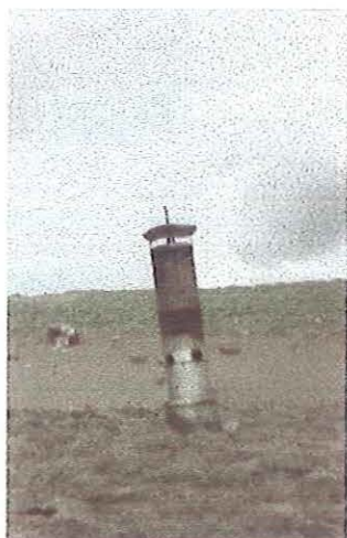
Figura 18: Sistema de queima de gases (aterro de São Carlos/SP)
