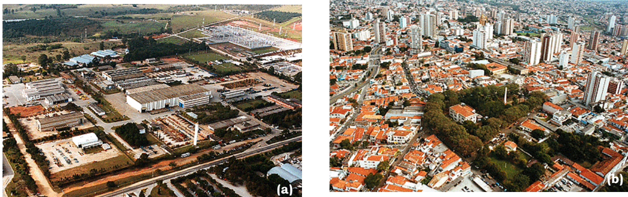
Figura 38 – Vistas Aéreas da área urbana do município de Sorocaba na UP9: (a) zona industrial e (b) região central (Fonte: http://www.sorocaba.sp.gov.br/secoes/sorocaba/fotos/fotos.php - (a)zonaindustrial1.jpg e (b)vistaaerea_centro1.jpg, 2007).
