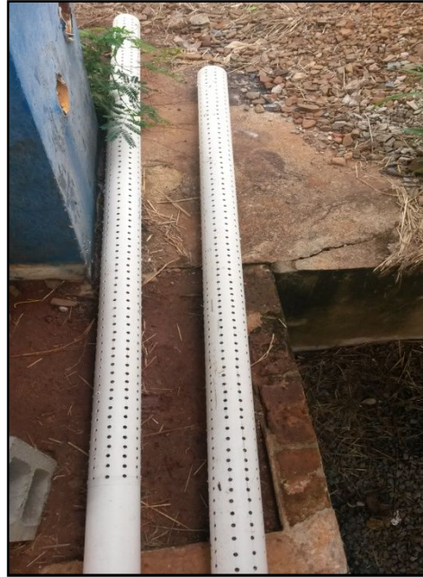
Figura 4. 8 - Tubulação perfurada para drenagem do biogás
