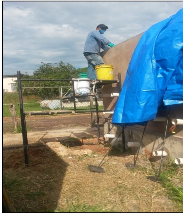
Figura 4. 15 - Preenchimento dos lisímetros
