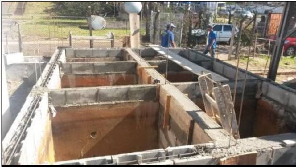
Figura 4. 4 - Construção dos lisímetros a partir dos tanques já existentes
