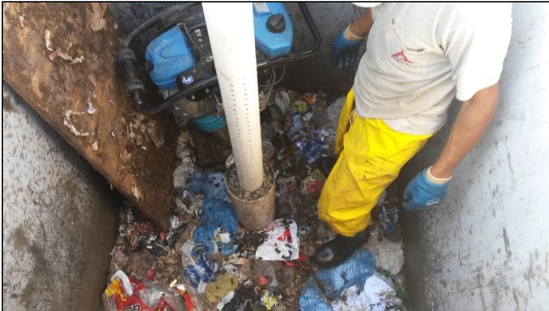
Figura 4. 16 - Compactação da camada de RSU
