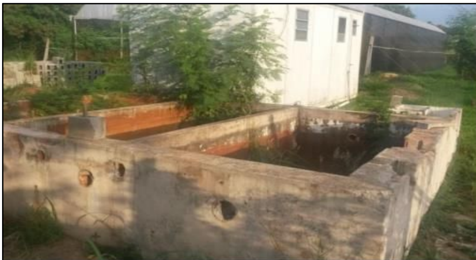
Figura 4. 1 - Tanques existentes antes da adaptação para os lisímetros
