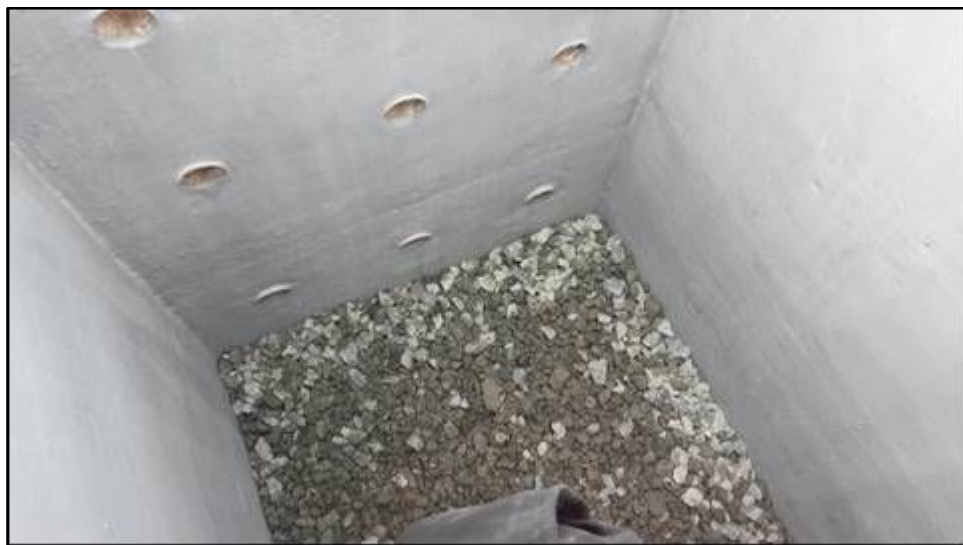
Figura 4. 6 - Camada de brita nº 4 para drenagem do lixiviado
